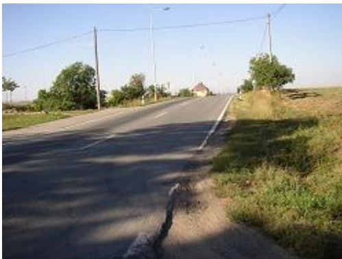
Obr. 19: Nedostatečný dohled na hlavní silnici (II/430, Rousínov)
