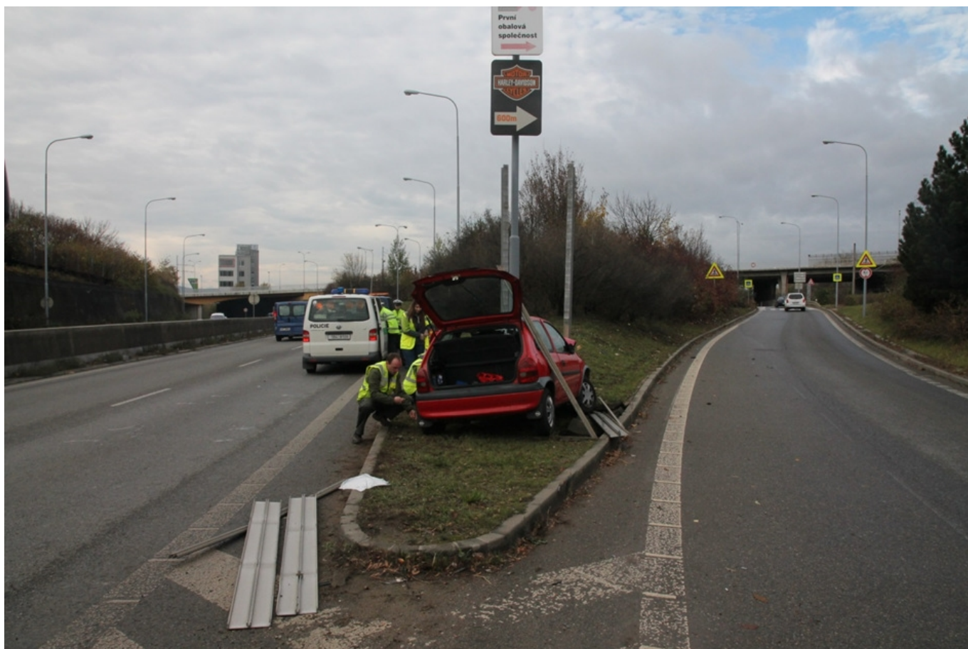
Obr. 2.5 - Pevná překážka provozu na rozštěpu ulic Porgesovy a Křížíkovy v Brně
