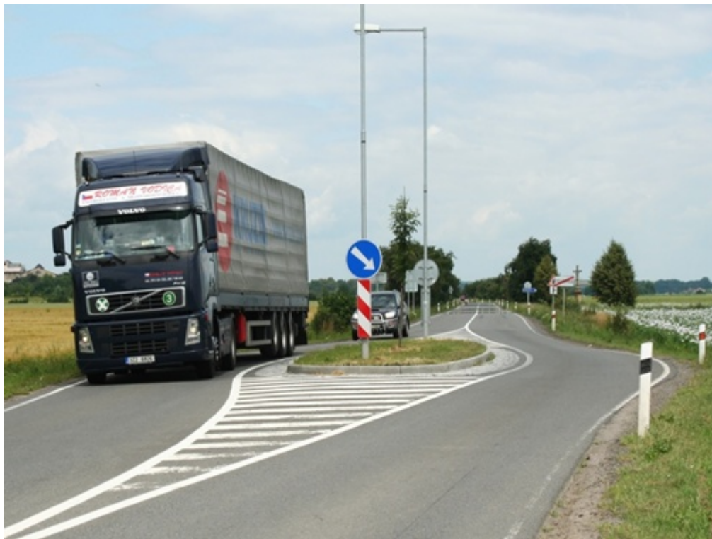
Obr. 2: Ochranný ostrůvek pro podporu přecházení – Prostějov.
