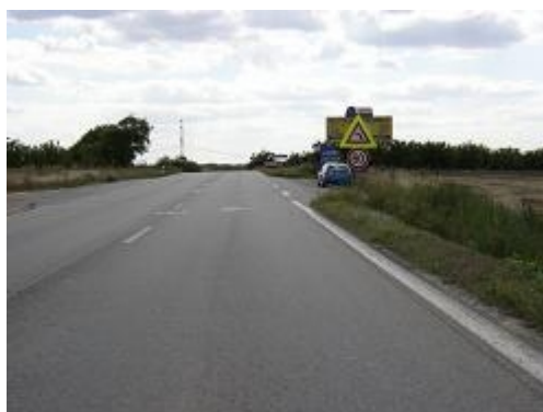
Obr. 4: Špatný kontrast značky na nevhodném pozadí (Brno-Přízřenice)
