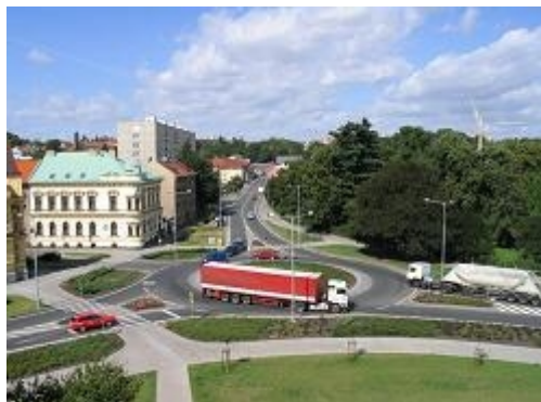
Obr. 23: Styková křižovatka nahrazená okružní (I/37, Chrudim)
