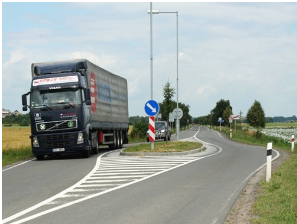
Obr. 2: Ochranný ostrůvek pro podporu přecházení – Prostějov.
