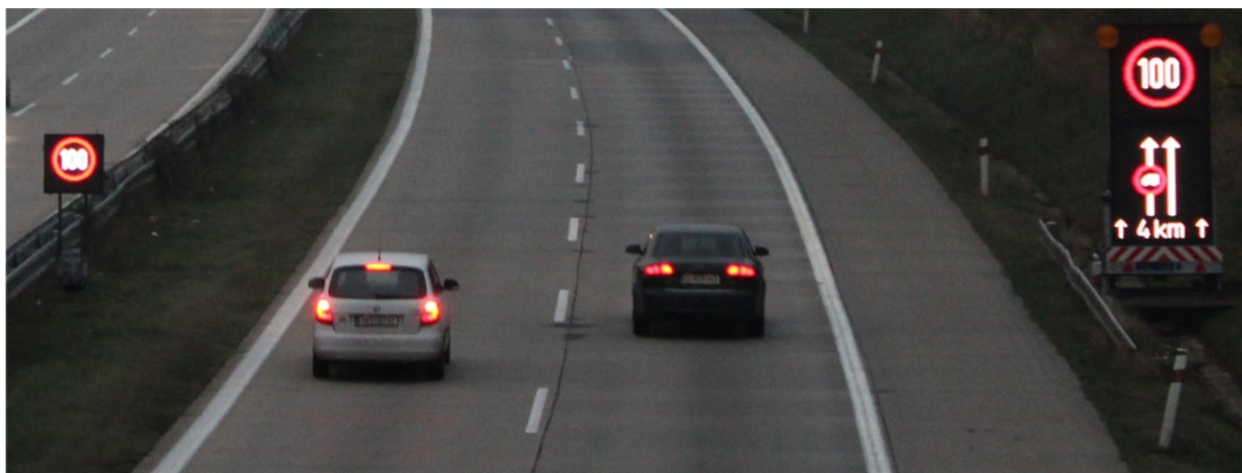
Obr. 2 - Fotografie z pilotního testování systému ViaZONE
