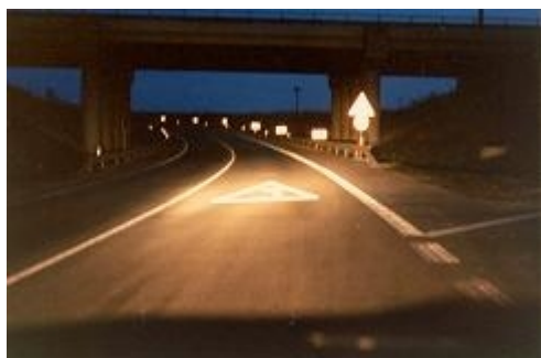
Obr. 2: Dříve nehodová zatáčka na okraji Písku (noc)
