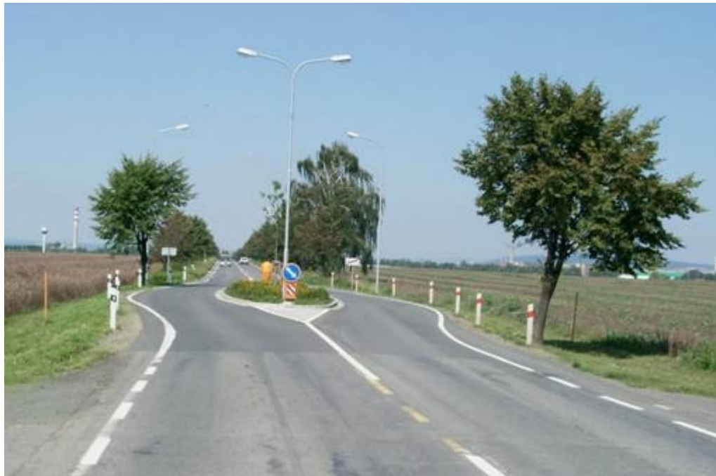
Obrázek 3: Definitivní řešení vjezdovým ostrůvkem (8/2006)
