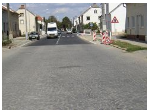
Obr. 12: Náhlá změna adheze povrchu (Pohořelice)
