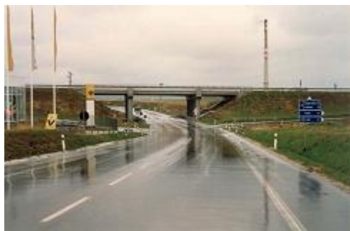
Obr. 1: Dříve nehodová zatáčka na okraji Písku (den)
