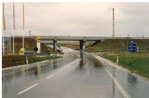
Obr. 1: Dříve nehodová zatáčka na okraji Písku (den)
