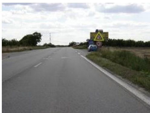
Obr. 4: Špatný kontrast značky na nevhodném pozadí (Brno-Přízřenice)
