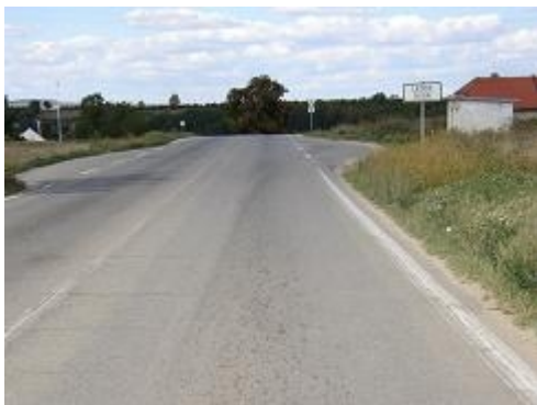
Obr. 9: Ztracená trasa - výškový zlom (stará I/52 Brno-Pohořelice)
