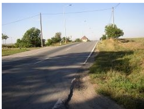
Obr. 19: Nedostatečný dohled na hlavní silnici (II/430, Rousínov)
