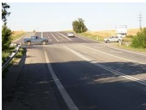
Obr. 22: Rozlehlá a nebezpečná kolizní plocha (II/430, Vyškov-Brno)
