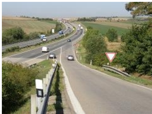
Obr. 11: Chybějící připojovací pruh (D 1, Rohlenka)
