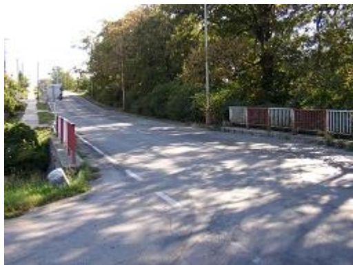
Obr. 18: Nákladní automobil zakrytý značkou (II/430, Rousínov)
